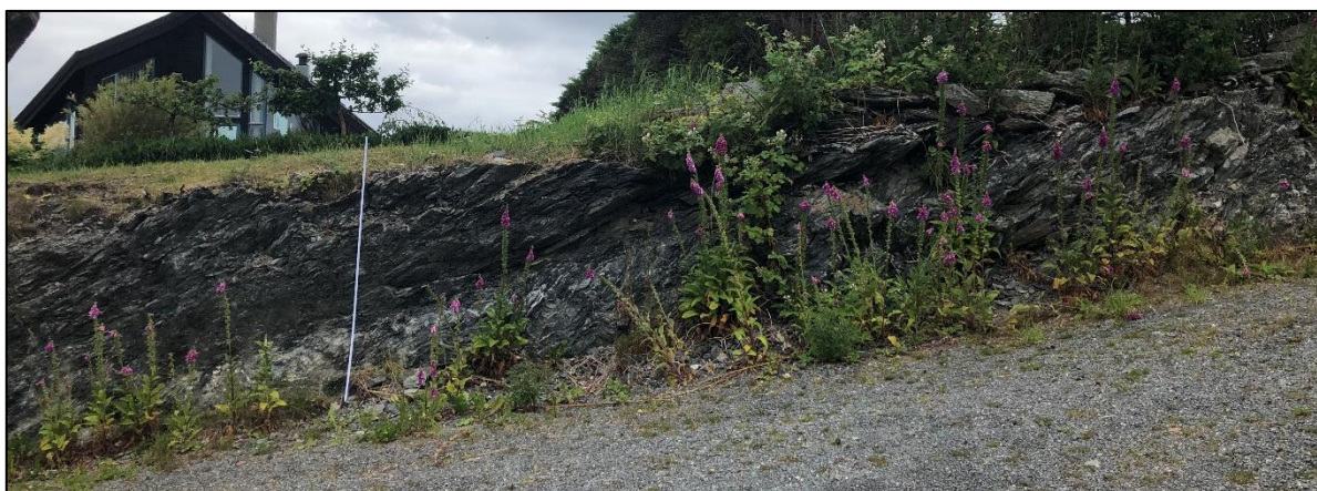
Foto 2 Midtre del av bergskjæring. Tommestokk på bildet er 2 m.
