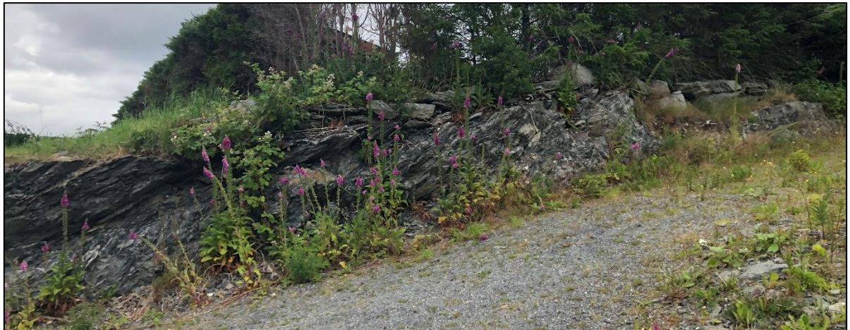
Foto 3 Østre del av bergskjæring.
